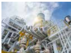
・油圧システム
